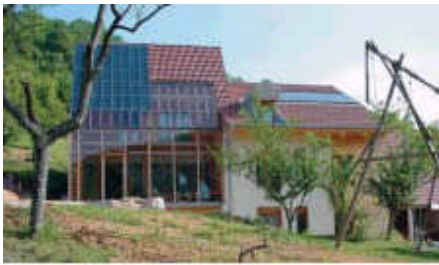
Maison individuelle à Besançon (Doubs) : 140 m 2 habitables, occupée par cinq personnes ; 16 m 2 de capteurs en toiture (avec un chauffage d'appoint séparé au bois).
