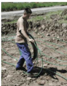
Pose de capteurs horizontaux
