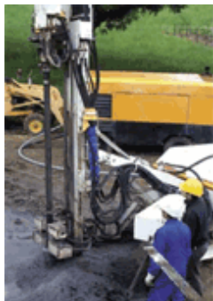
Pose d'une sonde géothermique
